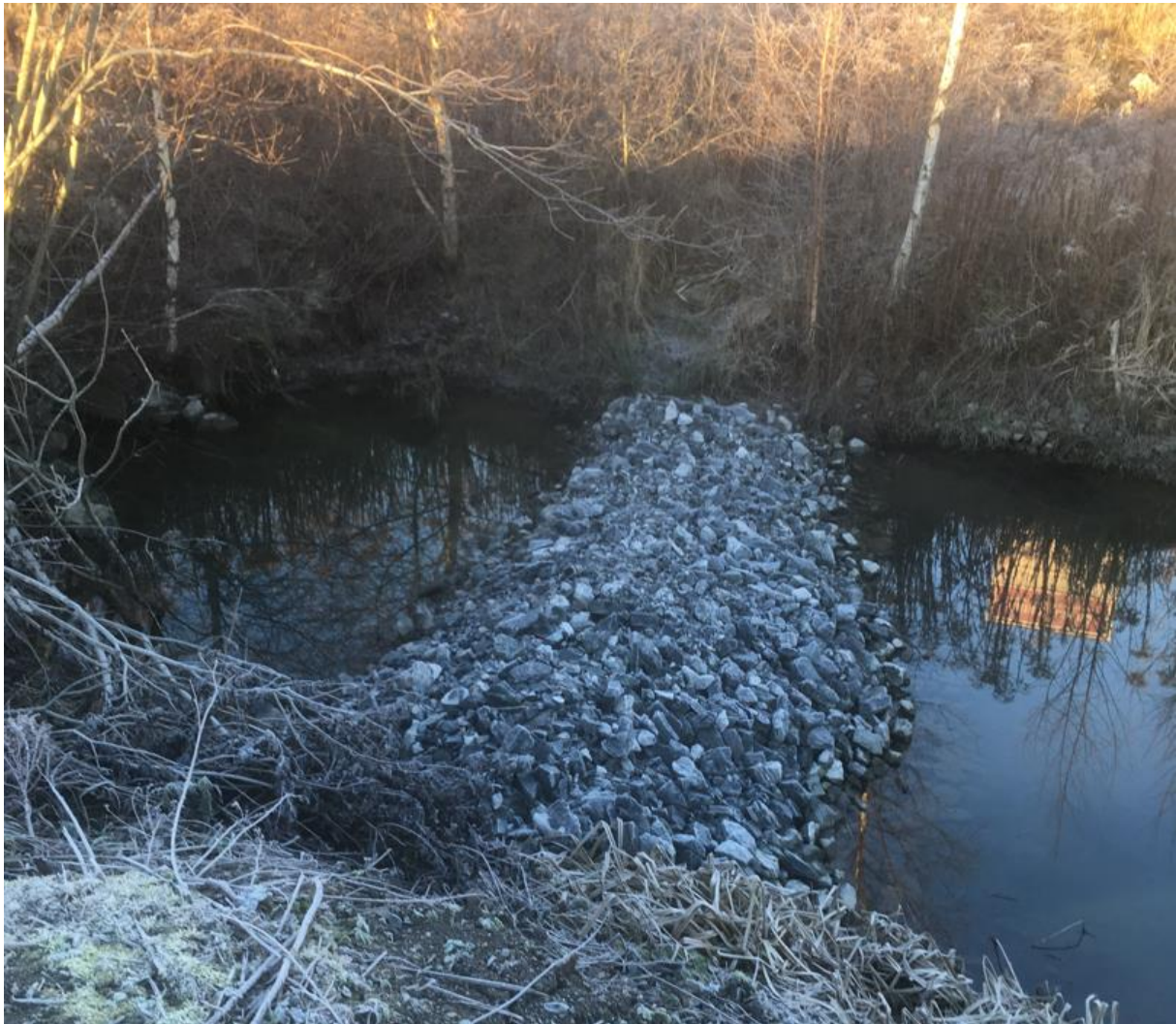
Figur 4. Terskel etablert i fordelingsdam nedstrøms pukkverk. Prøve 3 tatt oppstrøms terskel og prøve 4b tatt nedstrøms terskel. Foto tatt 17.12.21
