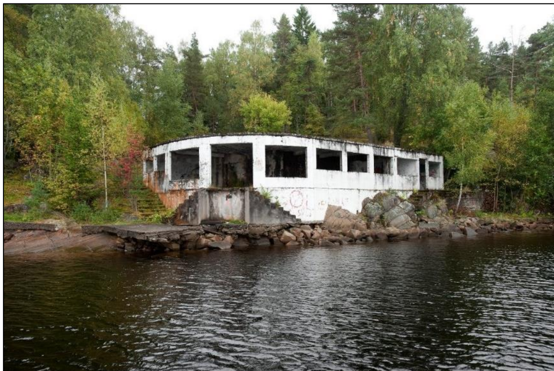
Figur 8. Eksisterende betongkonstruksjon sett fra sjøen.
