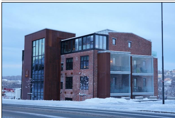
Figur 7. Planområdet 2022. Produksjonshallen øverst, servicebygget i midten og hovedbygningen (Batterifabrikken) nederst.
