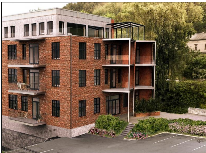
Figur 30. Bilde av Batterifabrikken. Her er de avbøtende tiltakene i form av utkragede balkonger som delvis er innglasset blitt en del av selve konstruksjonen og identiteten til bygningen.
